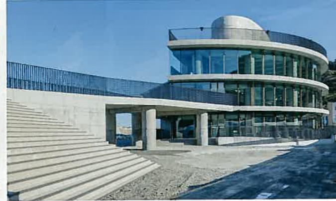
※ 津波の第一波からは大階段上に避難、第2波からは屋上避難により安全が確保される ※
