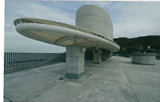
1,600人収容の屋上避難スペース 普段は展望台として利用される
