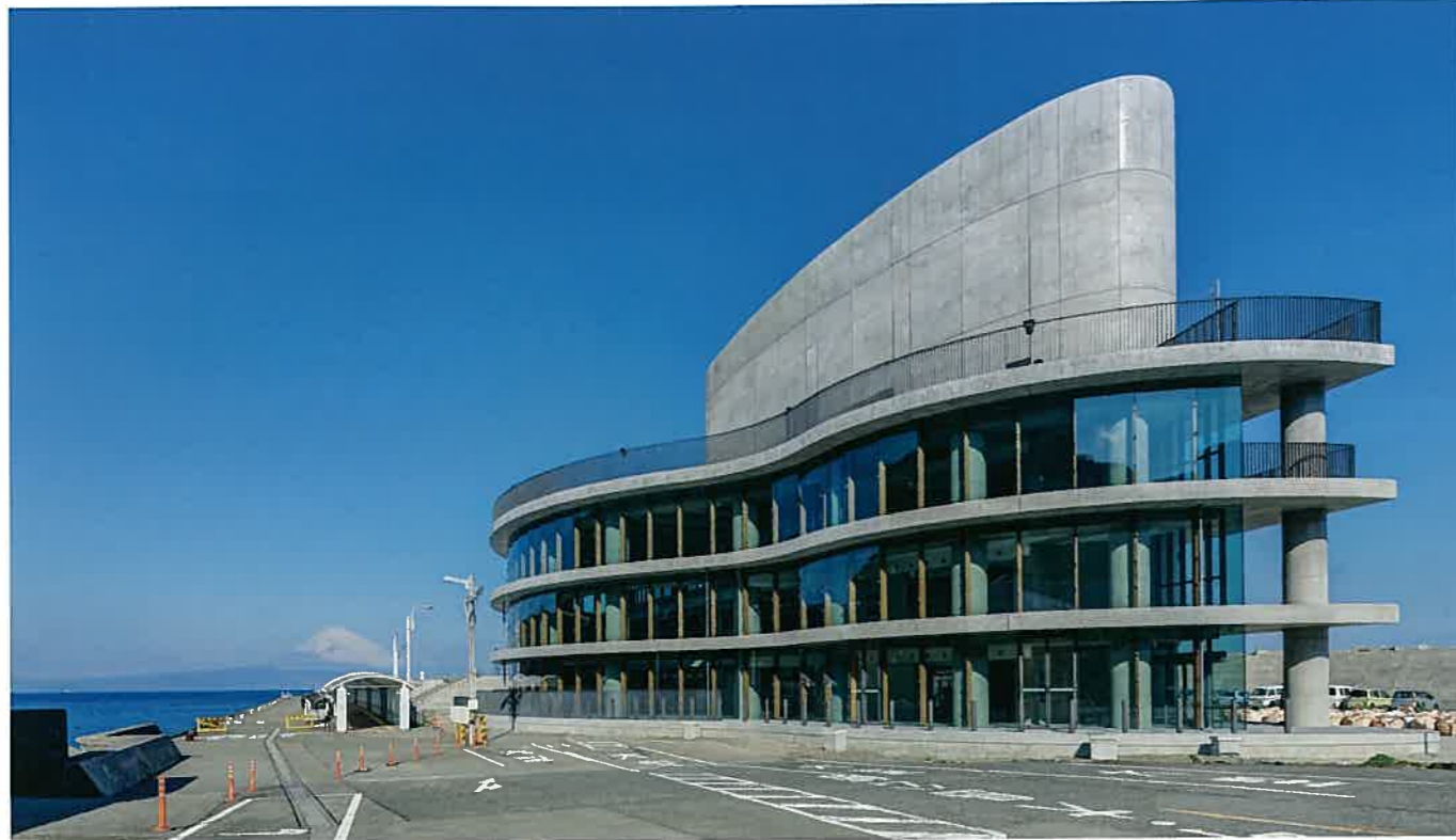
前面道路からの外観 1階から3階が船客待合施設、屋上に展望台兼用の津波避難スペース 外観を特徴づける鉄筋コンクリートフィンアーチが津波から建物を守る ※撮影: Ewix Inc. / 永江一弘
