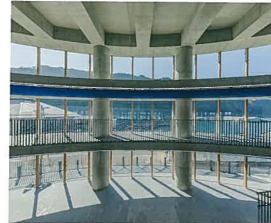
待合所から船の発着を見通す 災害時に万が一柱が1本破壊されても周辺の架構が床を支持する ※
